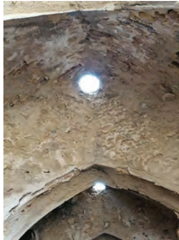
(الشكل رقم ٩-) الفتحة الدائرية التي تخترق وسط القباب في الأواوين الداخلية / من تصوير الباحث
